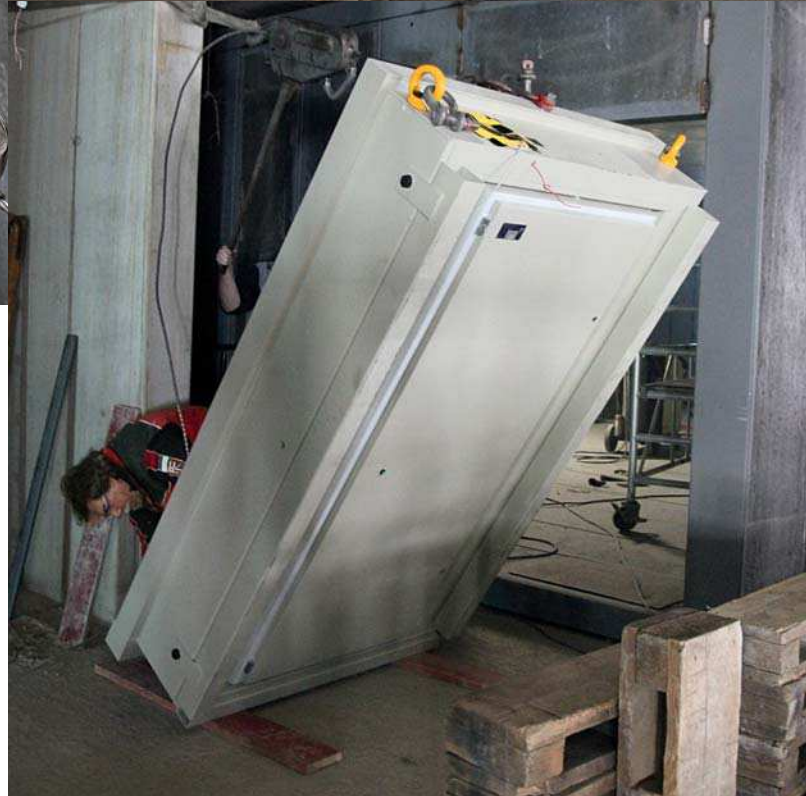
Eingespieltes Team: Martin Krug (linkes Foto) prüft die Position des Greifzugs. In der Bilderreihe rechts bockt Heinz Augustin (oben) mit dem Hydraulikstempel die neue Tresortüre auf. Gesichert vom Greifzug unterlegen Vater und Sohn (Mitte) die über drei Tonnen schwere Türe mit stabilen Palettenhölzern und bringen sie in Schräglage. Bevor die Tresortüre endgültig senkrecht steht, wirft Heinz Augustin (u.) nochmal einen prüfenden Blick auf die sichere Konstruktion.
